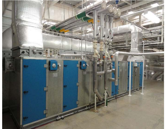
Figura 10. Unidad manejadora de aire No. 3.
